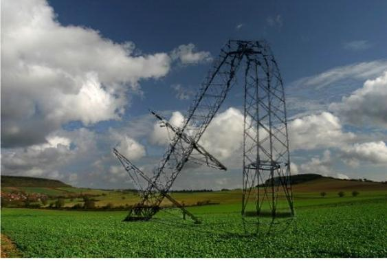
Un pylône de 50 m de hauteur s'est brisé et la pointe retombe sur le sol à 15 m de la base du pylône.
